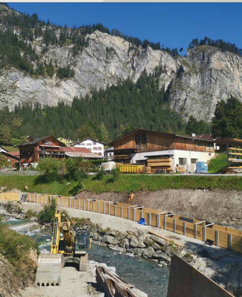
ZUFAHRTSRAMPE ZUR BAUSTELLE SOWIE KÜNSTLICHER BACHKANAL.
