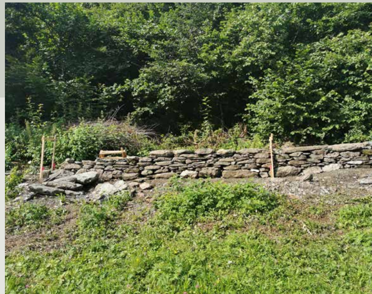
TEILABSCHNITT DER TROCKENMAUER.
